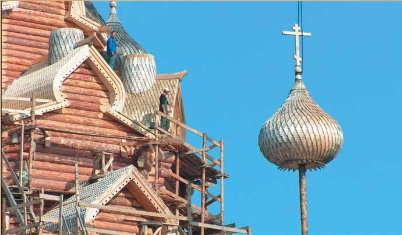
Строительно-монтажные работы: установка глав церкви. 2006 год
