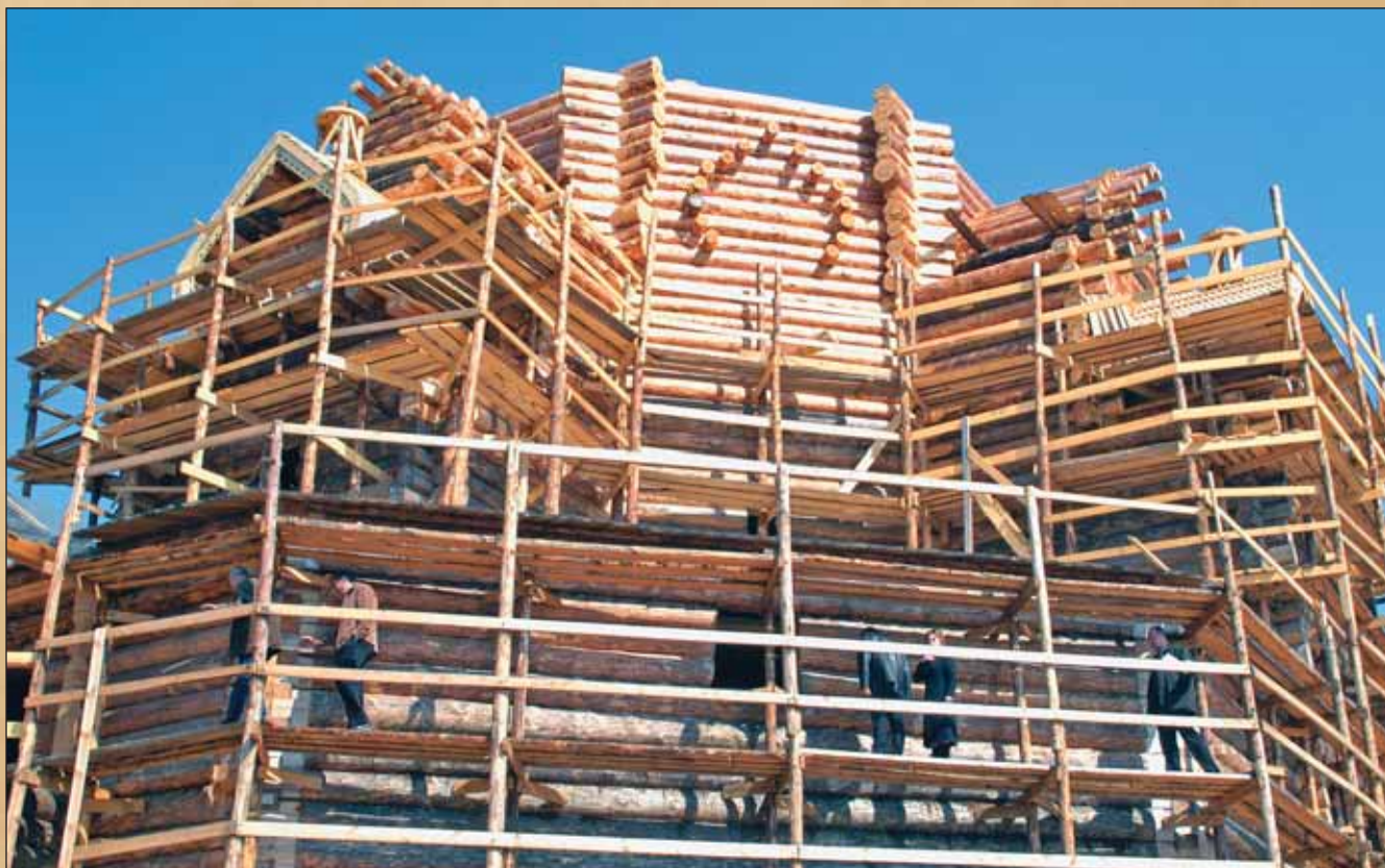
Сборка сруба церкви на стройплощадке в Невском лесопарке
