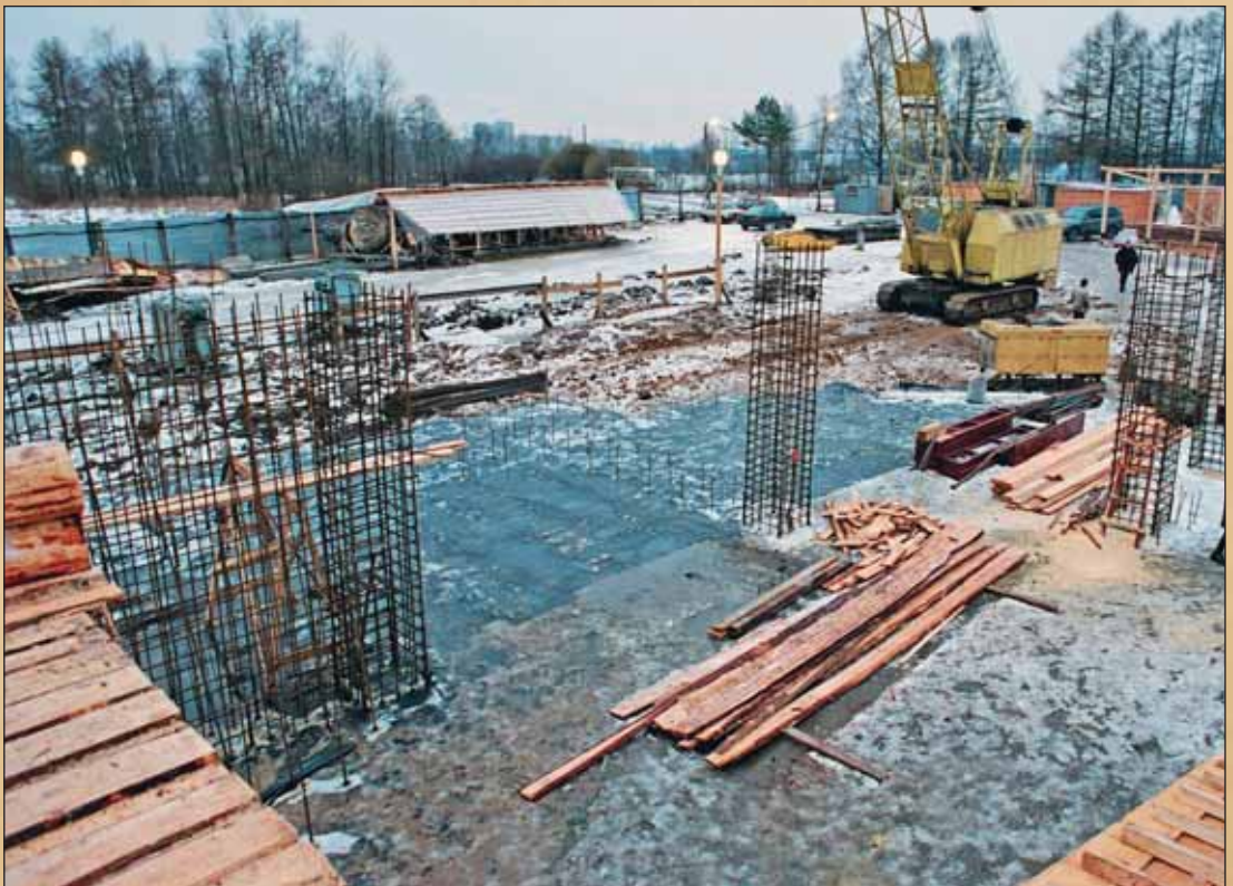
Заливка фундамента. Декабрь 2004 года
