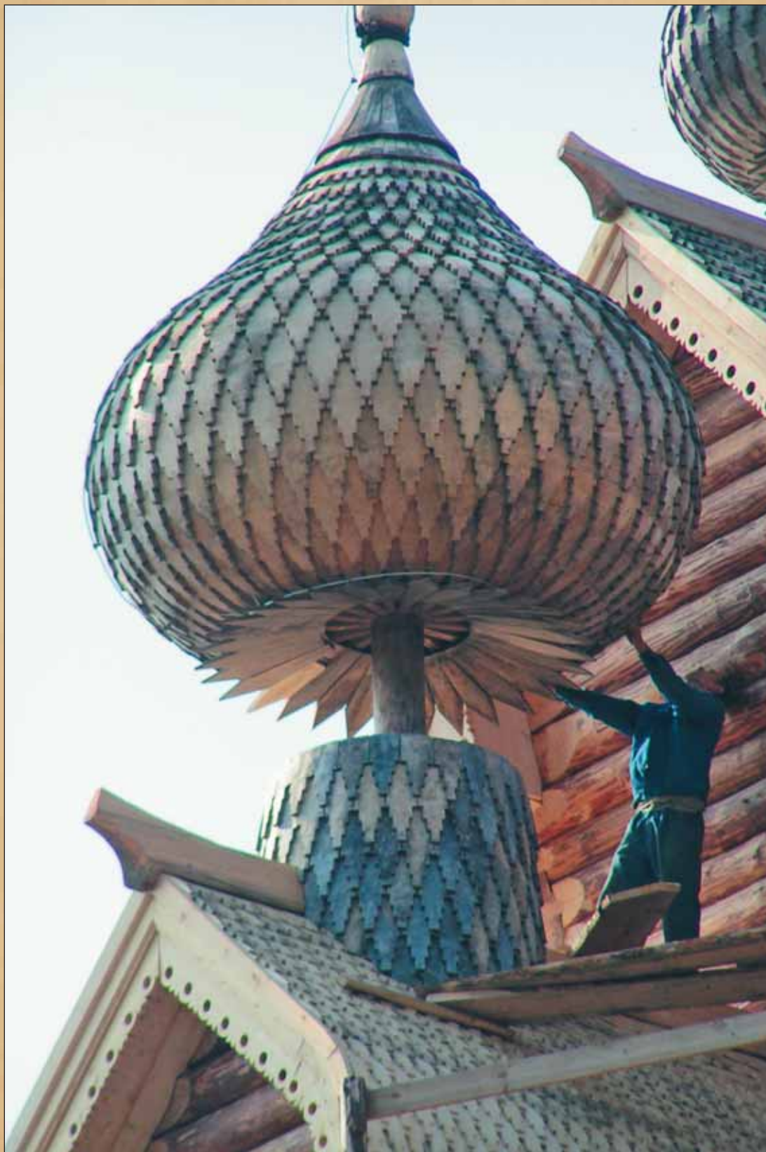
Строительно-монтажные работы: установка глав церкви. 2006 год
