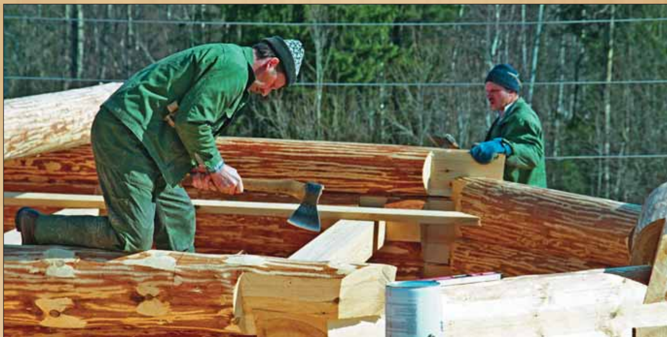
Изготовление сруба на базе в Карелии. 2004 год
